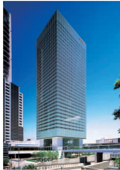
写真 3 JFE の制振ダンパーの適用物件の例 Photo 3 Example of buildings installed JFE hysteretic dampers
